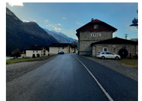
Der Vorplatz des Bahnhof Außerbraz wurde instandgehalten und neu asphaltiert.
