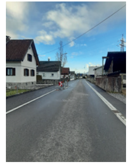
Die umfangreichen Bauarbeiten in der Klarenbrunnstraße konnten abgeschlossen werden.
